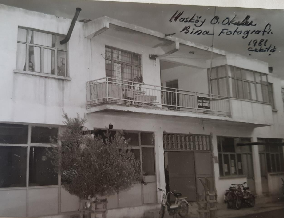
Hasköy Ortaokulu Bina Fotoğrafı (1981)
